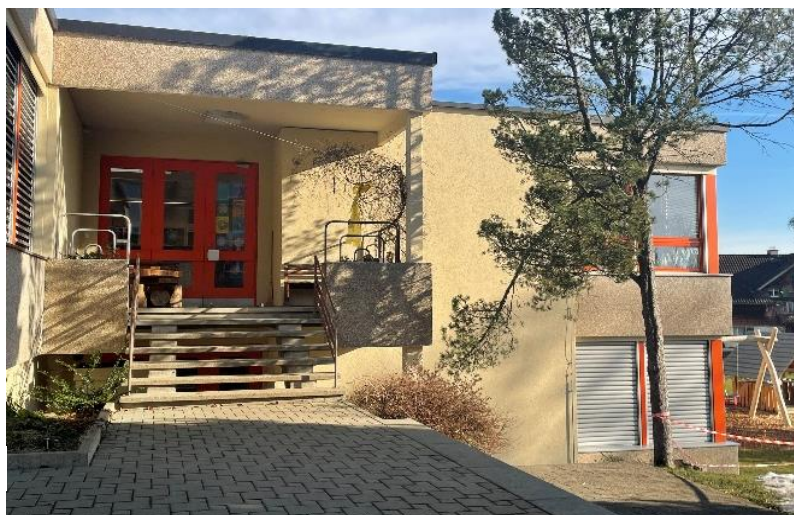
Sanierter Kindergarten Egger
