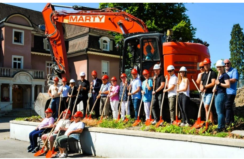
Spatenstich des Neubaus Geserhus
