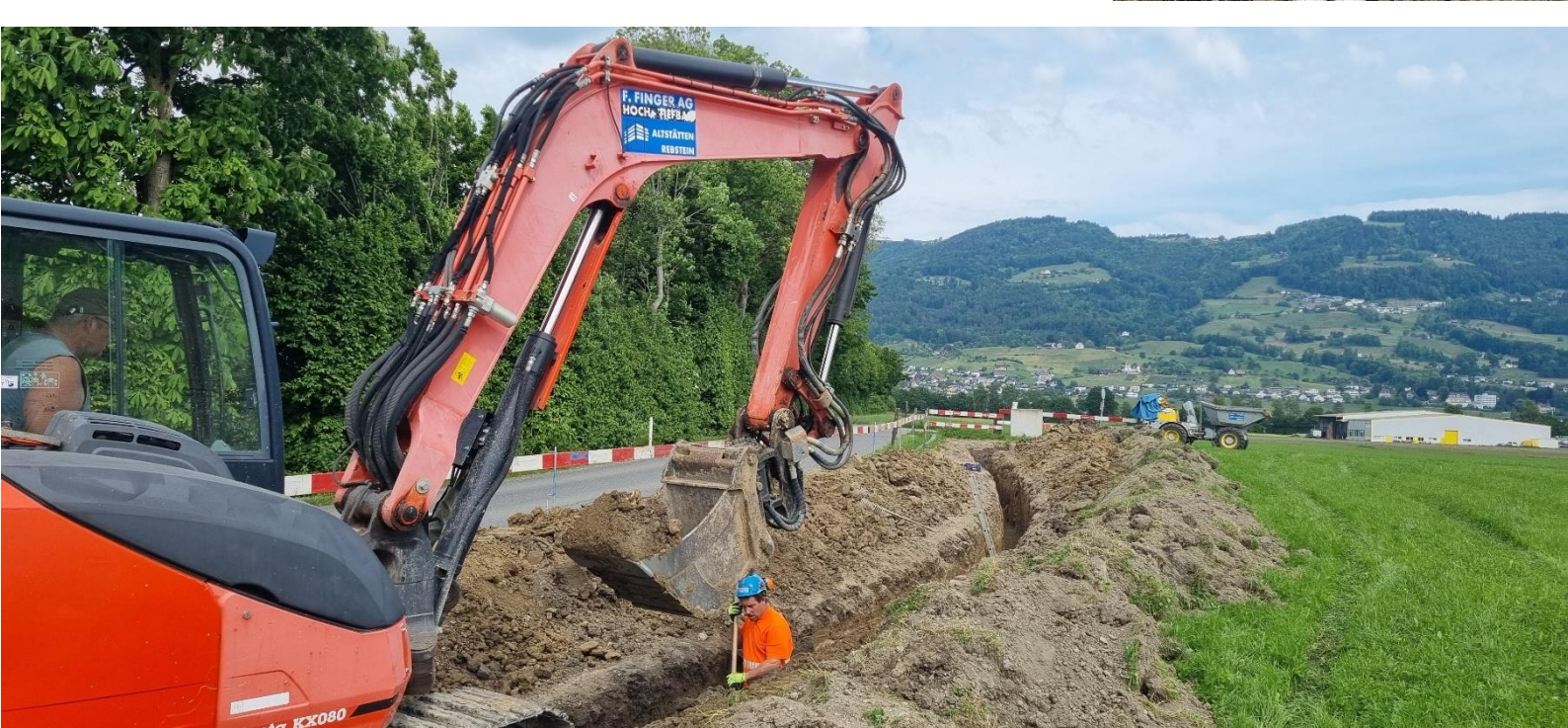
Sanierung Wasserleitung alter Anger bis Seegraben
